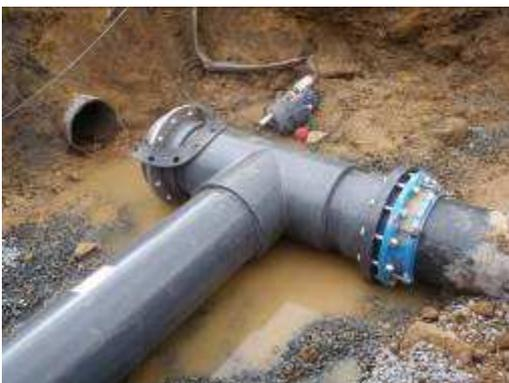
raccordement by-pass sur canalisation PEIMA
