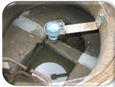
Exemple de capteur de déversement sur un déversoir d'orage
