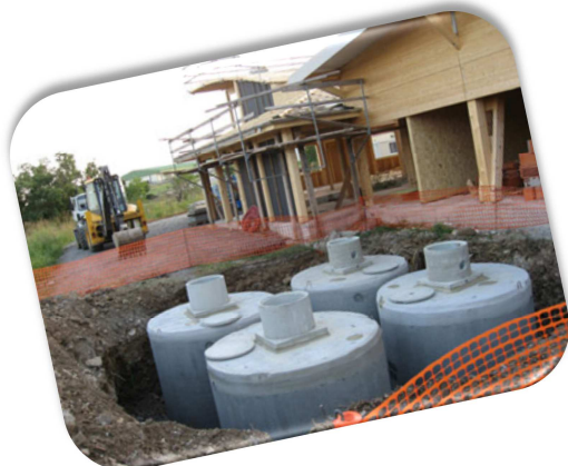
Cuves en béton préfabriquées pour la récupération d'eau de pluie (Source: www.ecosources.info )
