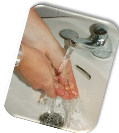
Exemple de robinet temporisé (Source : www.ecoresponsabilite.ademe.fr )
