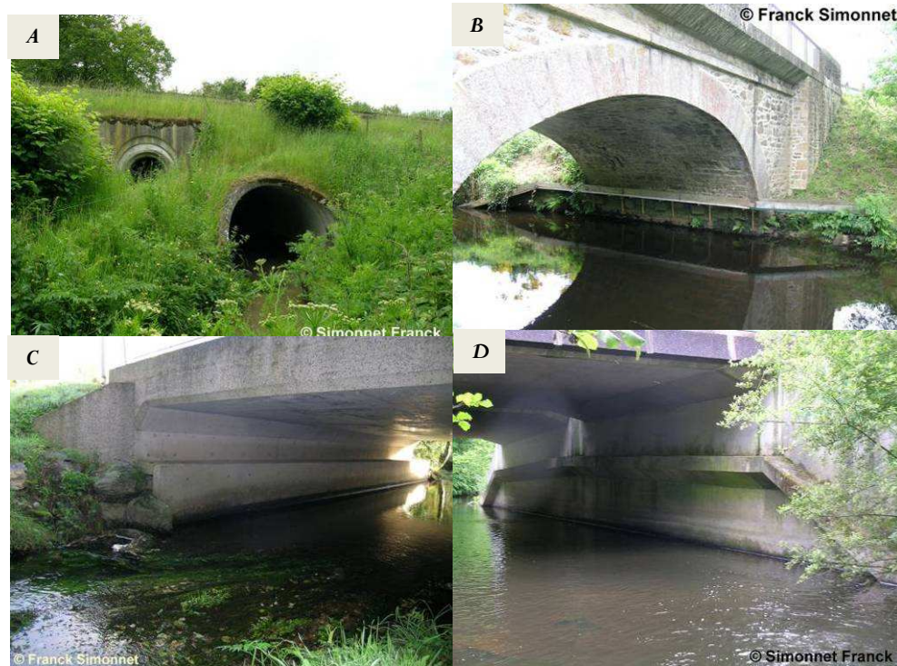
Exemples de passages à Loutre aménagés en Bretagne buse sèche (A), banquette en bois (B), banquettes en béton (C) et banquette en encorbellement (D)
