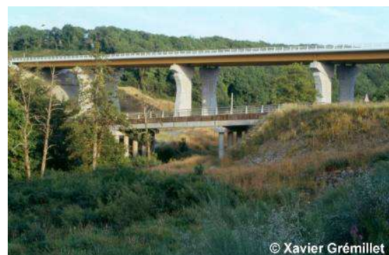
Figure 1 : Ouvrage de type viaduc
