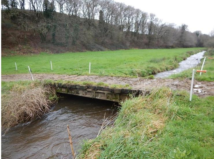
Les prairies humides sont accessibles par les laitières via un chemin d'exploitation conçu par l'exploitant pour accéder aux prairies sur l'autre versant. Le chemin a été décaissé sur 50 cm puis remblayé avec des cailloux et du sable pris sur place\*.
