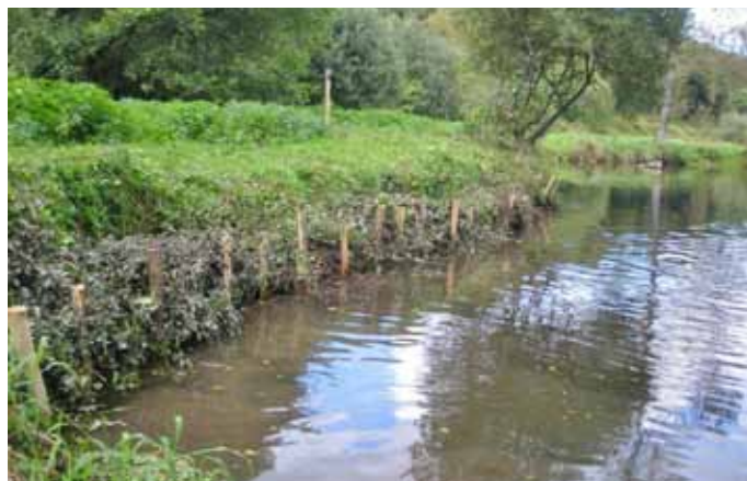
Restauration de berge : fagots de branchage (Elorn)
