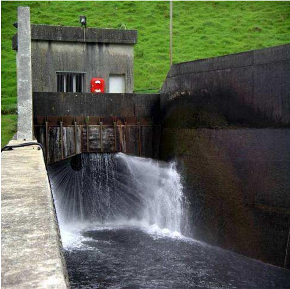
**Vue de l'exutoire du jet creux en aval du barrage**
