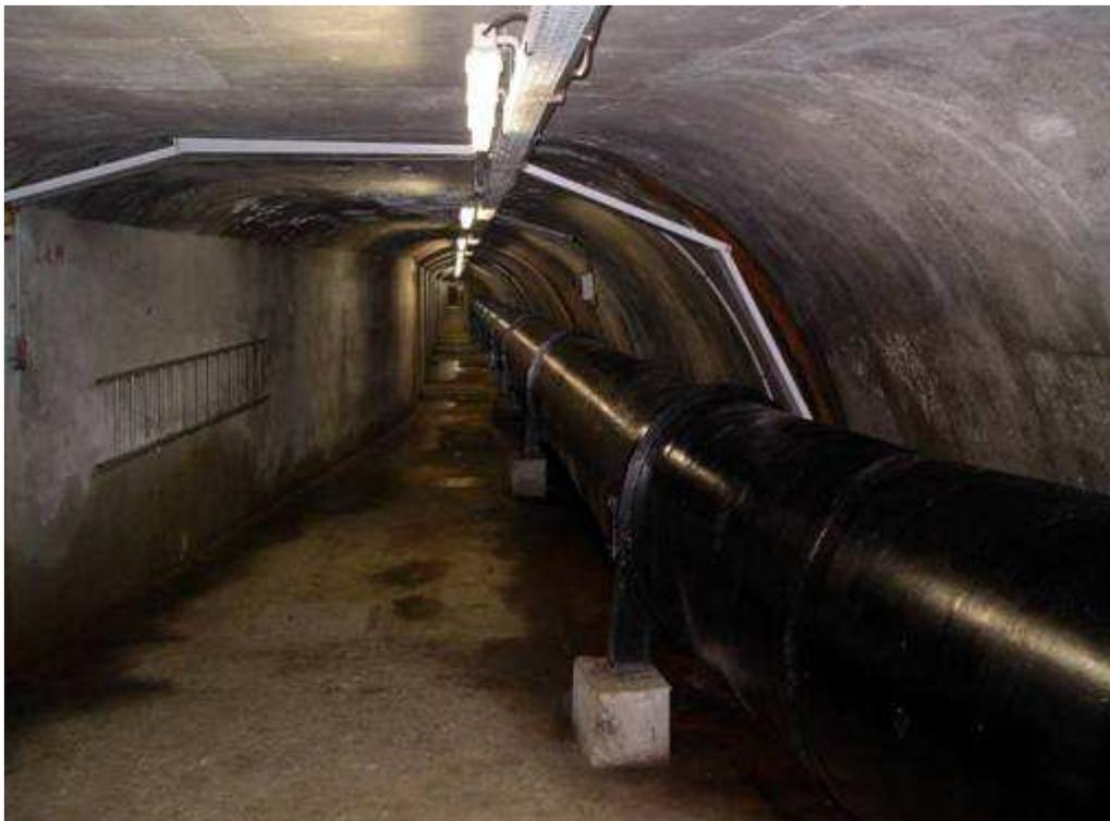
**Vue de la galerie supérieure et de la conduite du jet creux (Ø 800)**
