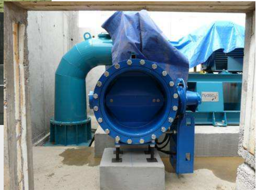
Connexion des arrivées et sortie d'eau
