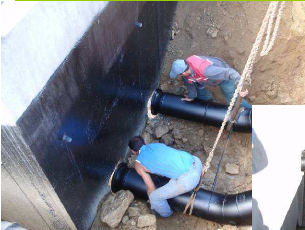
Pose des conduites
