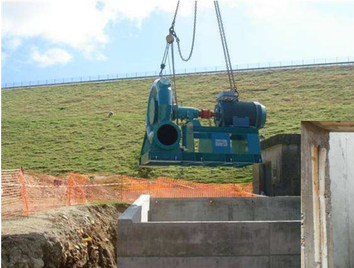
Pose de la turbine Francis dans la fosse principale
