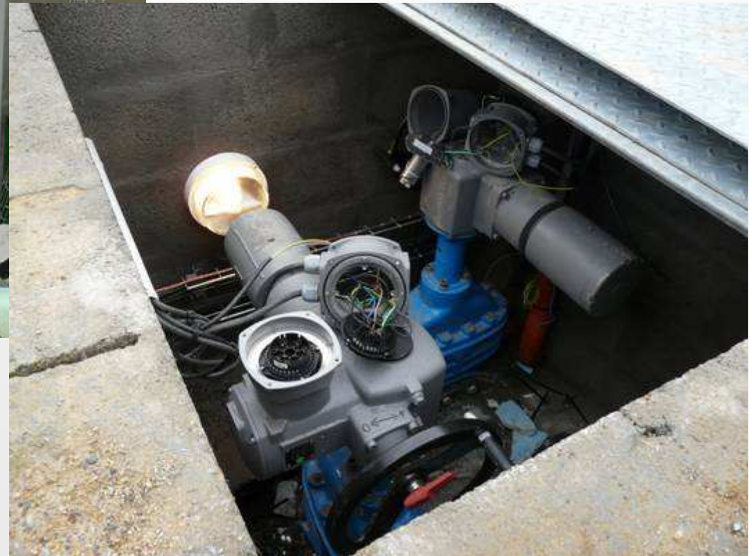
Branchement des vannes automatiques
