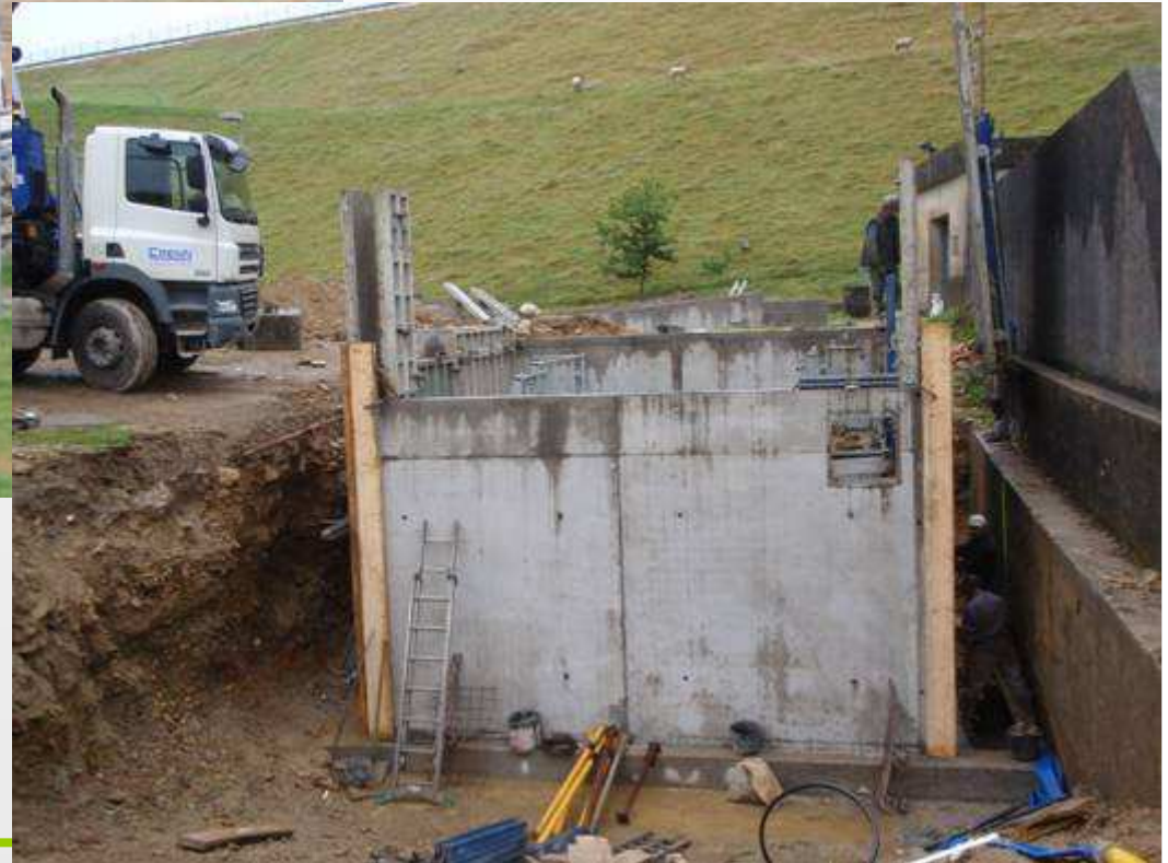
Construction des locaux enterrés
