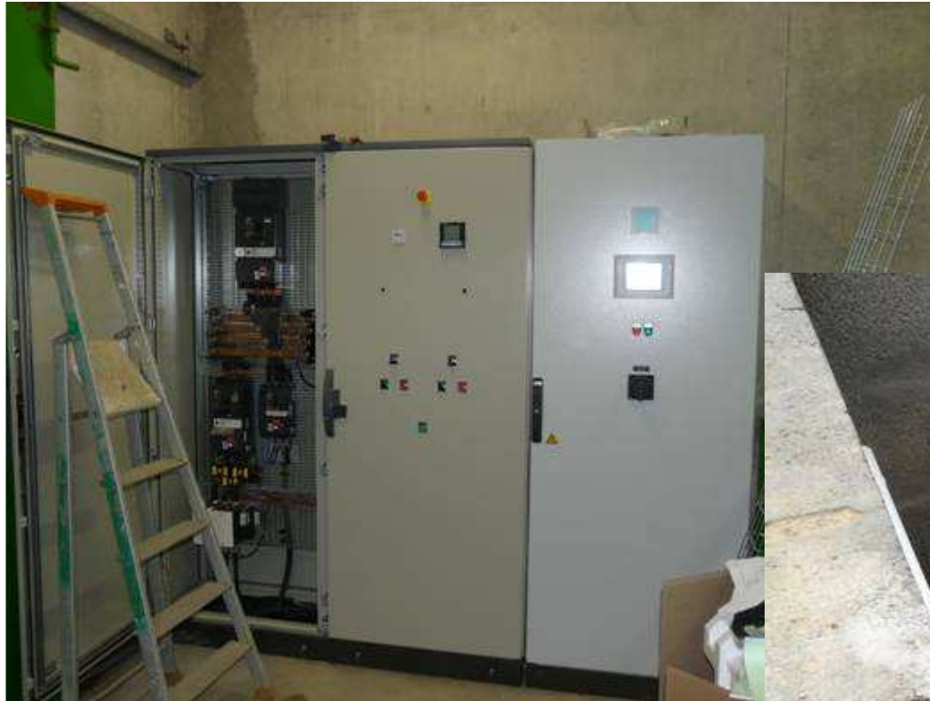
Installation des armoires électriques
