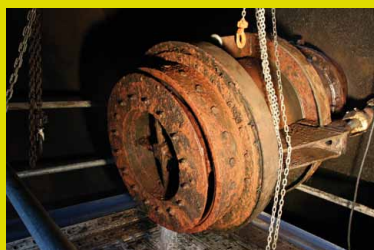
La vanne à jet creux avant et après rénovation
