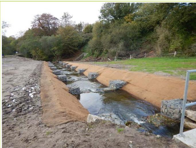
Le Quillivaron : bras de contournement de la partie aval du tunnel (seuils en gabions et toile en fibre végétale) - oct 2014
