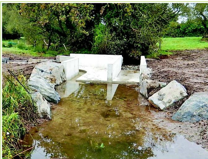
Répartiteur des débits vu de l'amont : à droite, canal du bief ; à gauche, canal du cours d'eau avec canal de débit réservé
