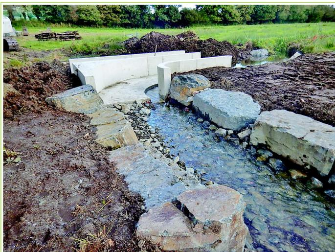
Répartiteur des débits vu de l'aval, enrochements anti-érosifs des berges et pavé d'armure du substrat
