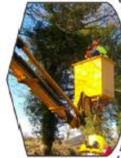
Coupe des branches gênantes à la tronçonneuse à l'aide d'une nacelle
