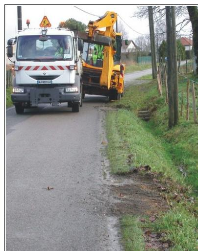
Figure 5. Saignées réalisées au tractopelle
