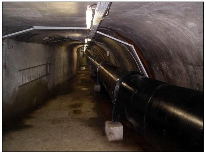
Figure 5 - Vue de la galerie supérieure et de la conduite du jet creux
