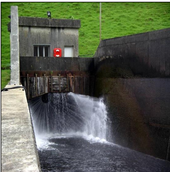
Figure 5 - Vue de l'exutoire du jet creux en aval du barrage
