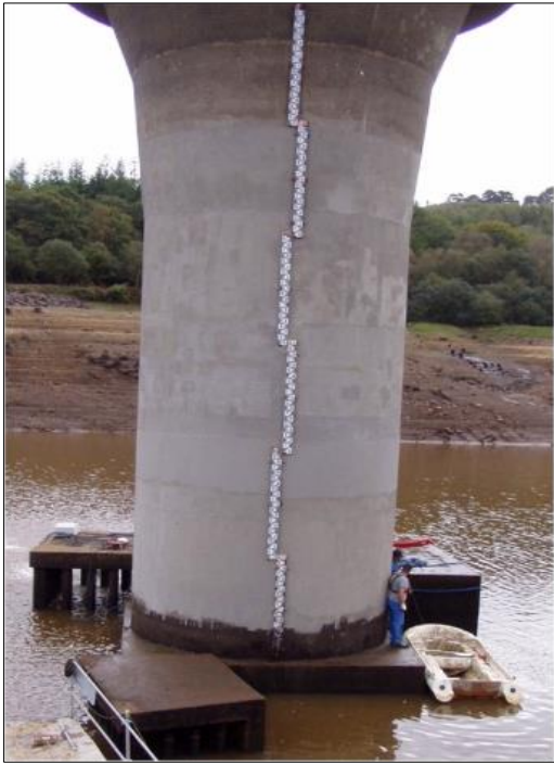
Figure 7 - Vue de la tulipe de trop plein et des prises d'eau des vannes, lors des travaux de vidange 2006
