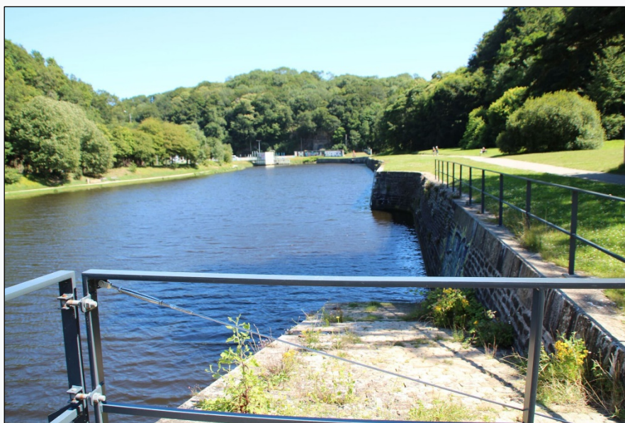
Figure 161 : Barrage sur la Penfeld. Au premier plan l'ancienne cale et le quai Riou-Kerhallet (Wiki-Brest, site collaboratif du patrimoine et du vivre ensemble à Brest) (Jaffrès et al., 2022)
