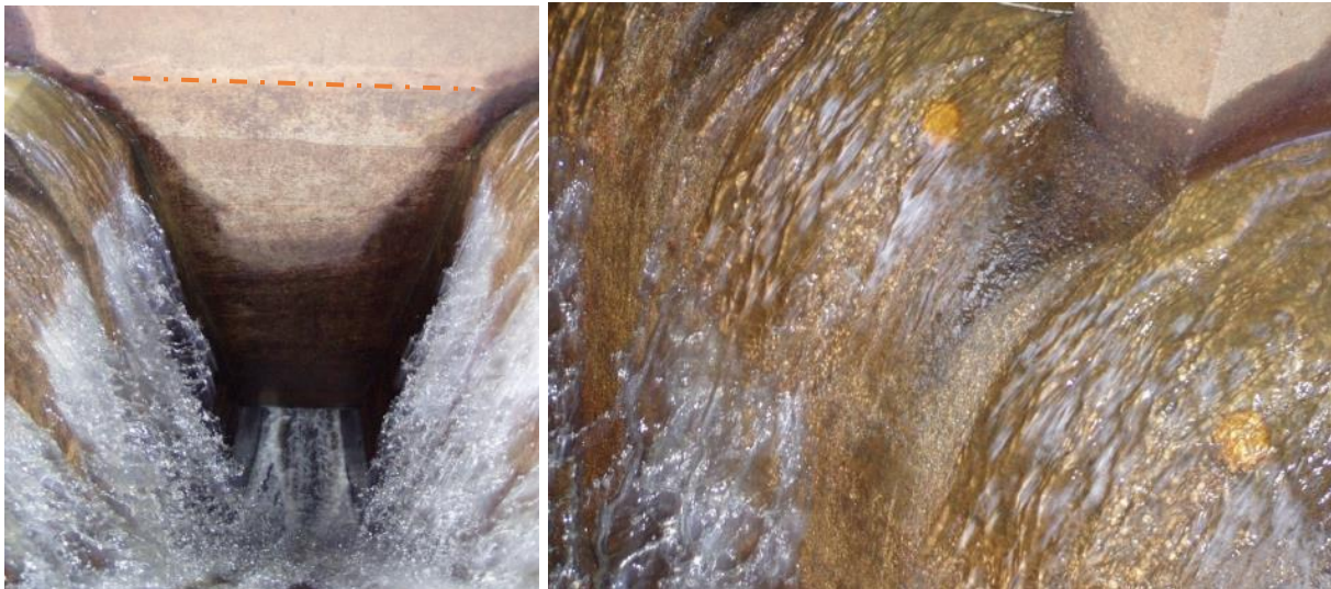
Figure 39 – Photos de la prise, vue externe et interne de l'entonnement (assec 2006)
