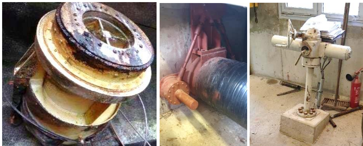
Figure 13 – Vanne à jet creux (buse de sortie, transmission et actionneur)
