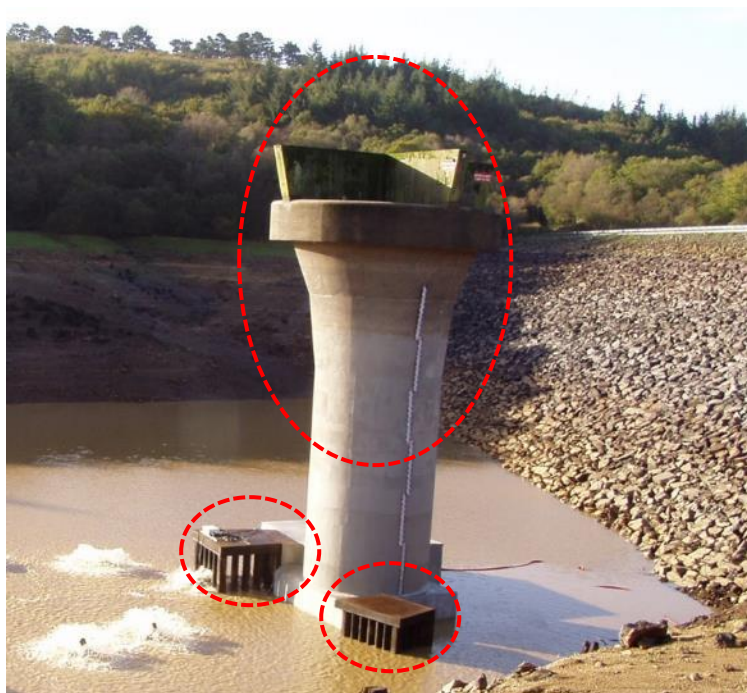
Figure 2 - Ouvrages de prise sur la tête amont [3]
