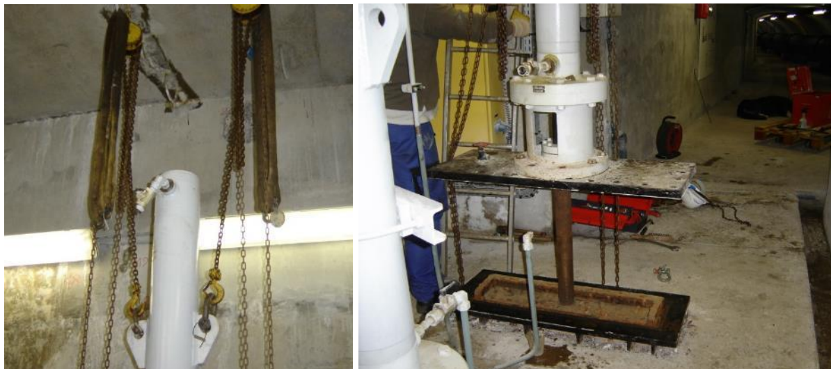
Figure 44 – Photo de l'extraction de la vanne V2 pour remise en peinture (assec 2006)
