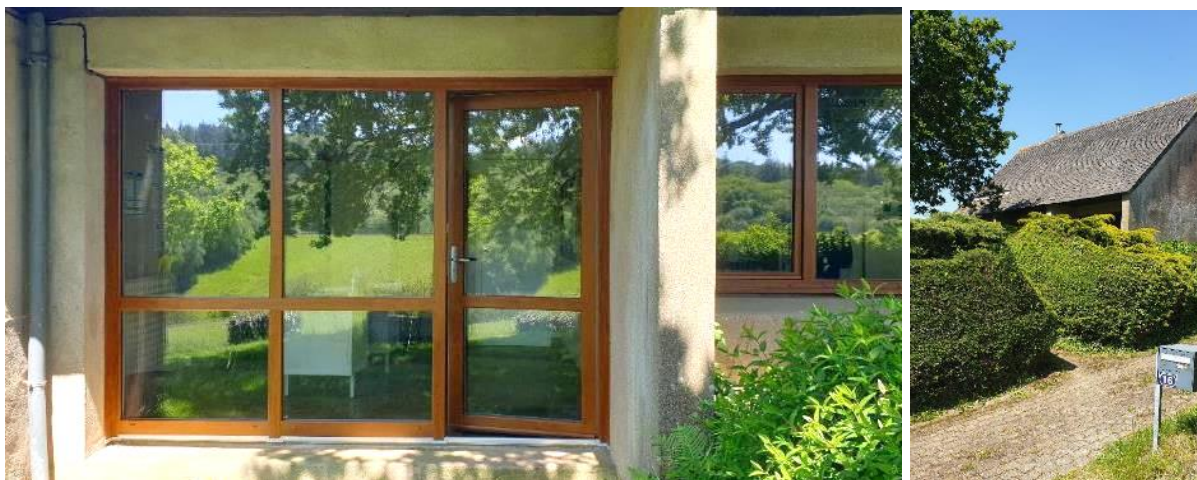
Figure 14 – Façade et entrée du bâtiment de commande
