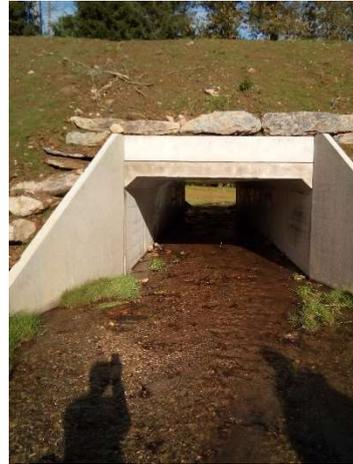
Après travaux : ruisseau renaturé en amont de la digue ; pont-cadre
