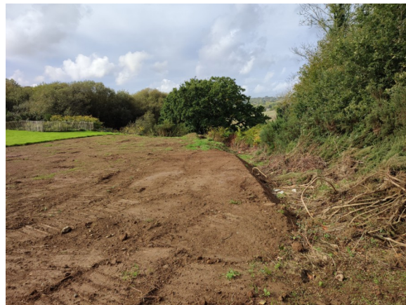
Station : aménagement urbain en cours
